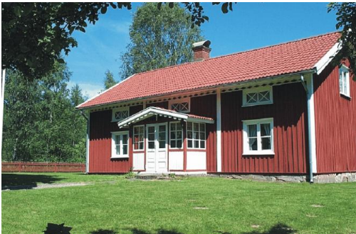
Le bâtiment principal de 1872. Les meubles datent du début du 20ième siècle.
